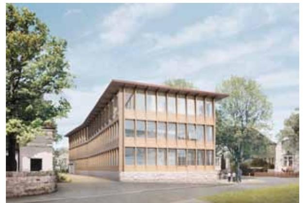
bauten der späten 1940er Jahre. In pools Neubau werden beide Referenzen auf der konstruktiven Ebene verschmolzen, indem die Decken als Verbundkonstruktion aus Holz und Beton gedacht sind. Mittels kaum merklicher Knicke im Grundriss und den leicht aus der Vertikalen gekippten Fensterebenen wird die Vertrautheit der gerasterten Fassaden um Gestaltungsmerkmale der Gegenwart ergänzt.
