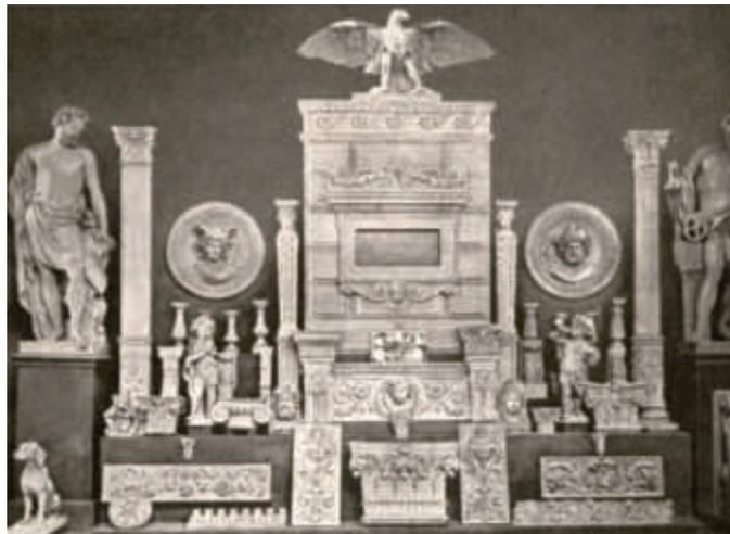
Betonwerker die Steinmetze abgelöst haben – das Ziel ist dasselbe geblieben wie vor neunzig Jahren: Kunststein ist Beton, bei dem das sorgfältig ausgewählte Natursteinmaterial die Körnung und Farbigkeit der Oberfläche bestimmt – und nicht der Zement.
