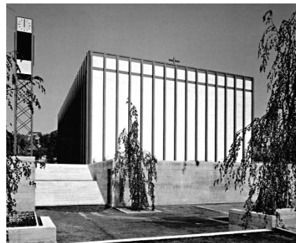
Franz Füg: Piuskirche, Meggen, 1966. Aus/In: Walter Zschokke: Nachkriegsmoderne Schweiz. Basel: Birkhäuser Verlag 2001. S./p. 139
