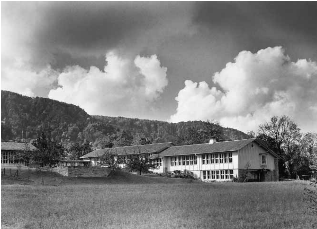
A. H. Steiner, Schulhaus Bachtobel in Zürich, 1947: traditionelle Form, rationelle Bautechnik. – Bild: Rudolf Schmutz, Archiv gta
