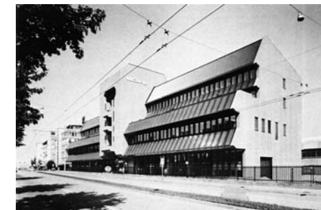
Pierre Robert Sabady mit Bruno Winkler, Bürogebäude der Maschinenfabrik Micafil in Zürich-Altstetten, 1979. Aus: Schweizer Ingenieur und Architekt, Heft 45 1979. S. 907
